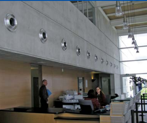
Dysze dalekiego zasięgu firmy TROX na Targach Motoryzacyjnych IAA Frankfurt, Niemcy
